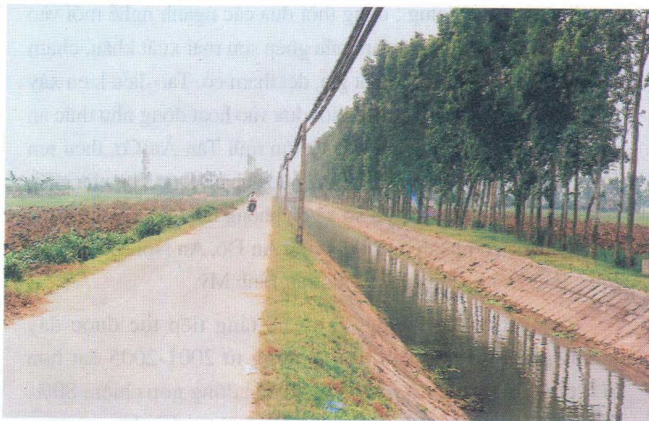
Đường giao thông nông thôn và kiên cố hoá kênh mương huyện Bình Lục (xây dựng năm 2004).
