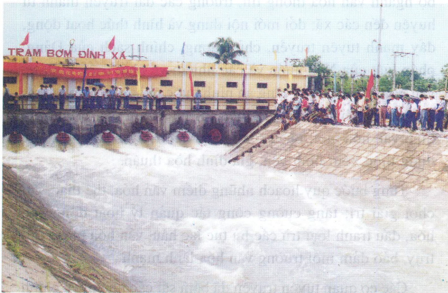
Trạm bơm Đình Xá, công suất 48.000m 3 /h khánh thành năm 1997.
